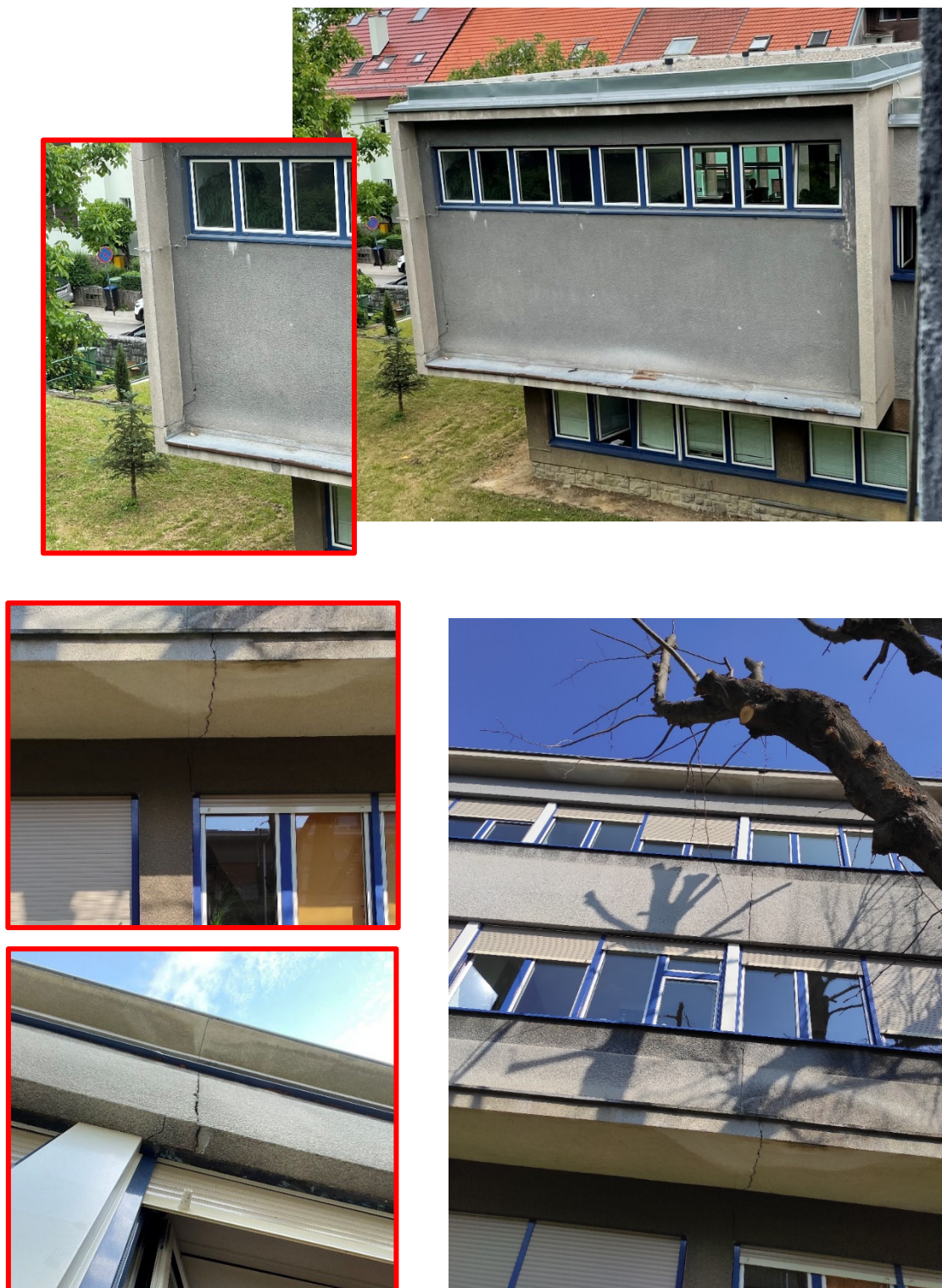
Slika 23. Pukotinsko oštećenje na pročeljima zgrade
