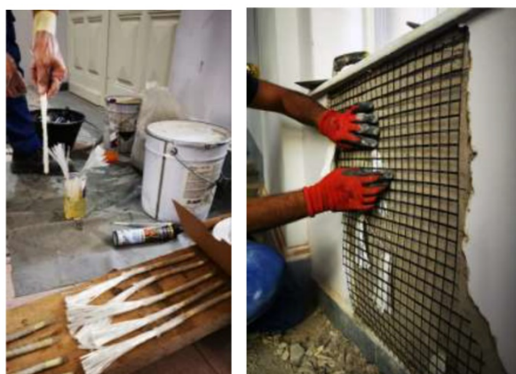
Slika 29. Postupak pripreme užadi (lijevo) i postupak nanošenja FRCM mrežice (desno)
