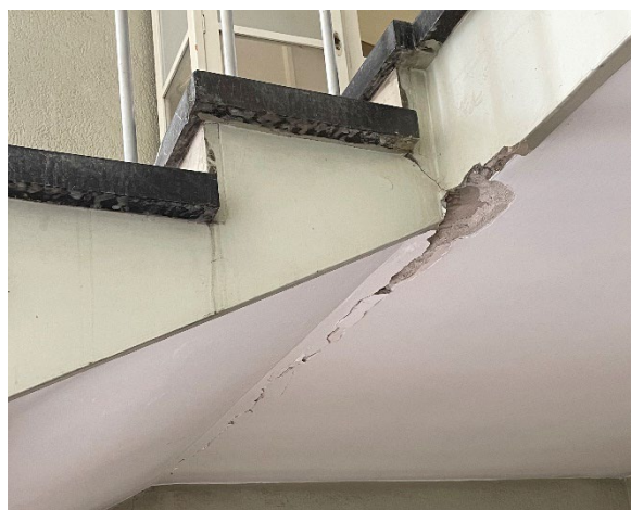
Slika 20. Pukotinsko oštećenje na kraku stubišta S1 (krak međupodest – podest 2. kat)
