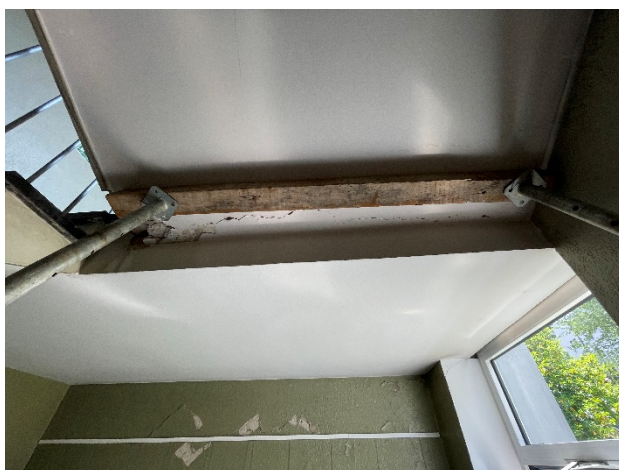
Slika 20. Pukotinsko oštećenje na kraku stubišta S1 (krak međupodest – podest 2. kat)
