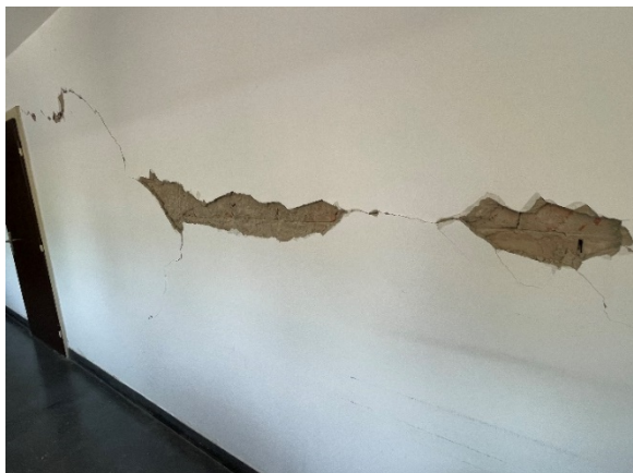
Slika 12. Karakteristično pukotinsko oštećenje prvoga kata
