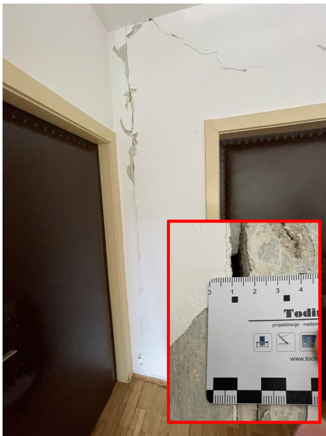
Slika 10. Pukotinsko oštećenje na dijelu gdje je strop i pod odvojen letvicom (moguća dilatacija – oznaka 2.15)
