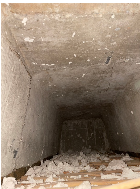
Slika 2. Detalj sitnobrečastog stropa i podgleda stropa prizemlja zgrade
