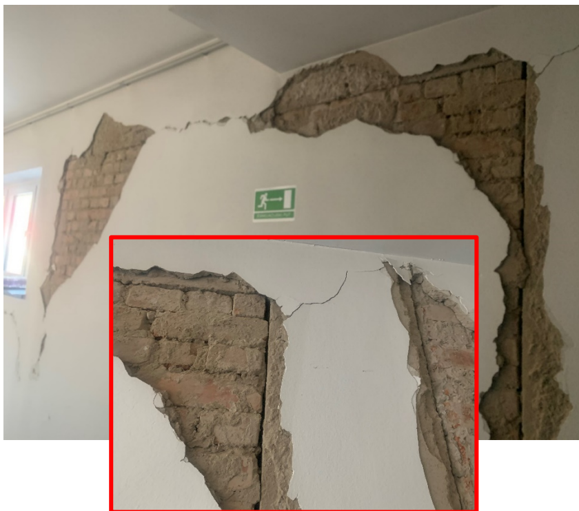
Slika 10. Pukotinsko oštećenje na dijelu gdje je strop i pod odvojen letvicom (moguća dilatacija – oznaka 2.15)
