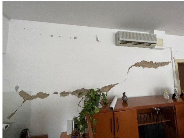
Slika 12. Karakteristično pukotinsko oštećenje prvoga kata
