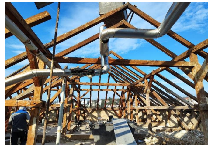
Sanacija krovne konstrukcije
