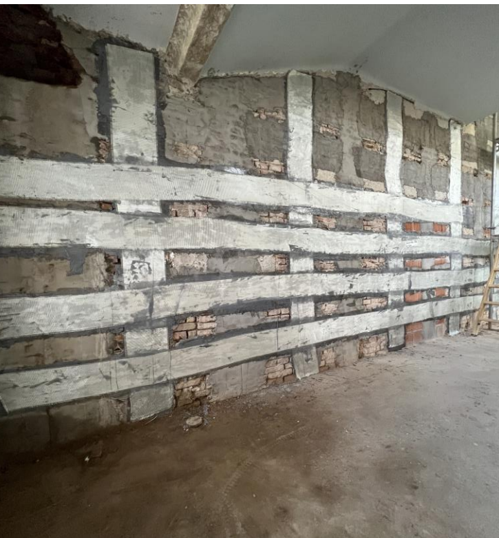
Ojačanje zidova GFRP jednosmjernim tkaninama
