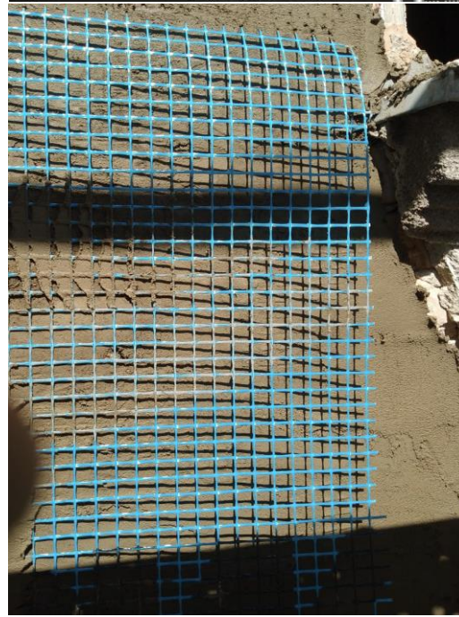
Ojačanje fasadnih pročelja FRCM sustavom - lokalno na mjestu oštećenja
