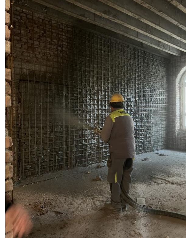
Ojačanje zidova torkret betonom
